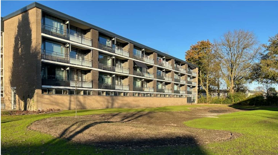
Flat 2: na de werkzaamheden (nieuwe balkonhekken en wadi)
